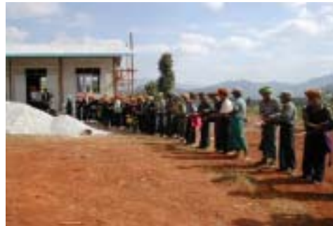
村人総出で子ども達のために労働奉仕を行った 床下に敷く石をバケツリレー
